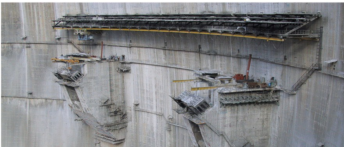
ساخت و نصب بخش پوشش فلزی سد کارون ۴ با تناژ بیش از ۴۴۰۰ تن
