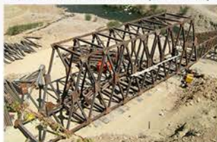
پل ۸۱ متری چال فهره لرستان
