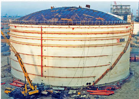
مخزن ذخیره فاز ۱ پارس جنوبی South Pars phase 1, storage tank
