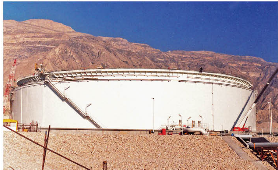
مخزن ذخیره دو جداره فازهای ۲ و ۳ پارس جنوبی South Pars phase 2, 3, double wall storage tank
