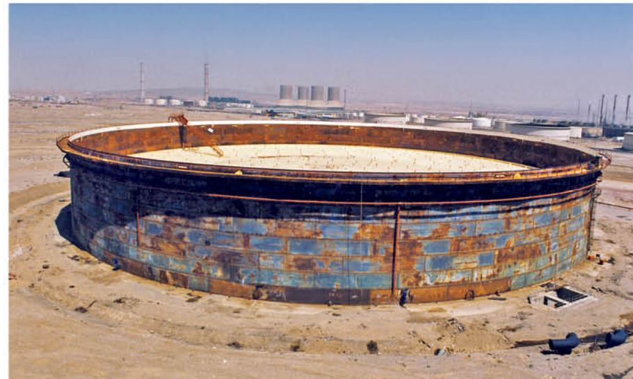
مخزن ذخیره سقف شناور به ظرفیت ۱۳۳۳۰۰۰ بشکه پالایشگاه اصفهان Isfahan refinery floating roof storage tank Cap.: 1333000 bls.
