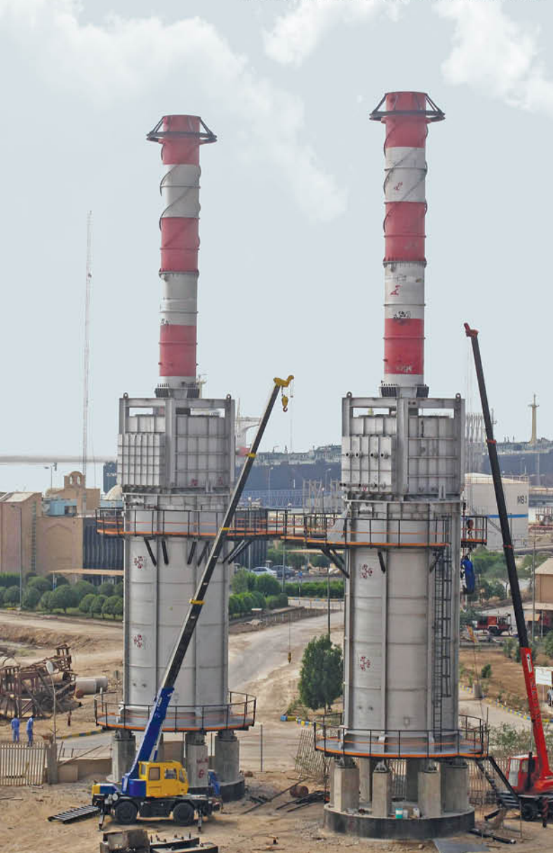
فایر هیتر پروژه اسکله صادراتی ماهشهر Maahshahr terminal revamp project fire heater
