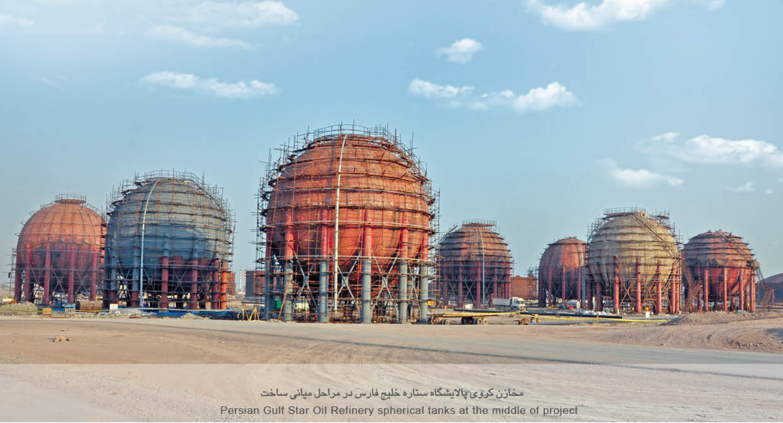
مخازن کروی پالایشگاه ستاره خلیج فارس در مراحل نهایی ساخت Persian Gulf Star Oil Refinery spherical tanks at the end of project
