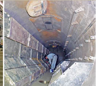
مونتاژ قطعات داخلی استیم درام Assembling of internal pieces of steam drum ▼
