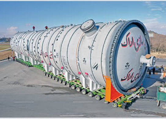
برج اصلی پالایشگاه امام خمینی شازند Shazand Imam Khomeini oil refining main column
